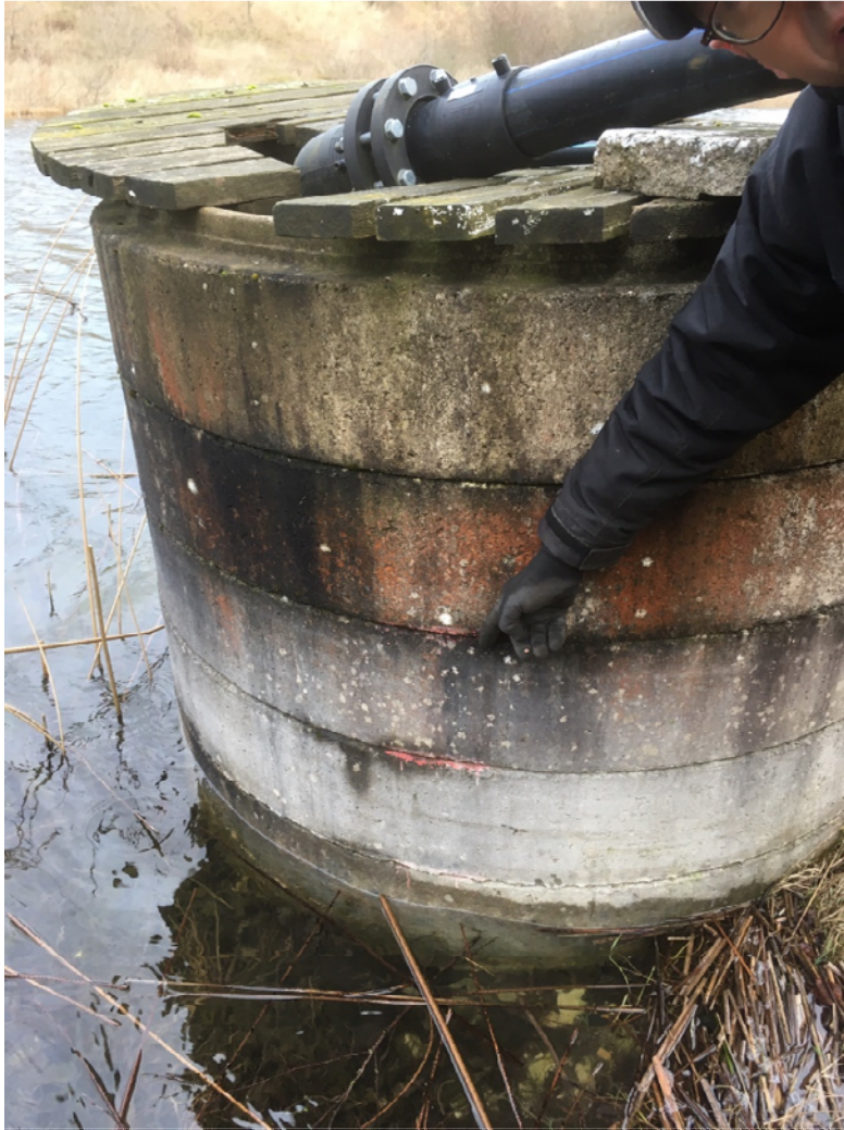
Foto af pumpebrønden (4. februar 2020). Vandstanden måles fra det øverste røde mærke, dvs. fra underkanten af den 2. øverste brøndring.
